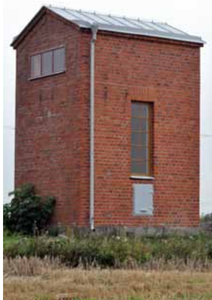
F.d. Transformator tornet efter det ställningarna rivits. Foto: Magnus Hellyerd
